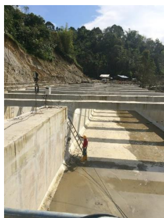
沈砂池。 コンクリート表面の仕上げ 作業等を実施中
