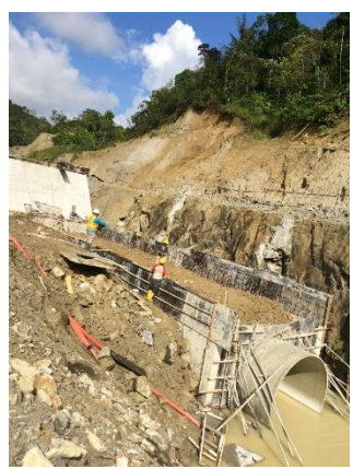
沈砂池出口の送水管 (GRP 管) 埋設工事
