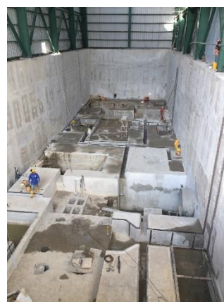
発電機室内 (タービン & 発電機) 基礎工事
