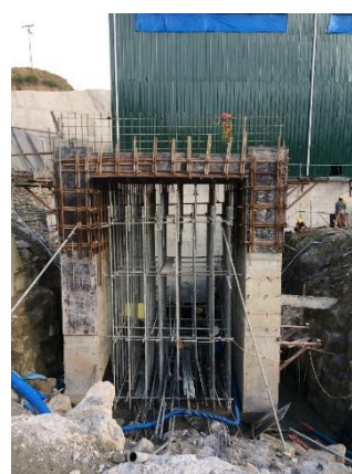
発電機室外の放水路 (タービン # 2)
