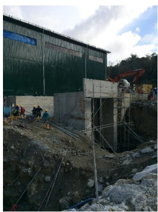
発電機室外の放水路 (タービン # 1)
