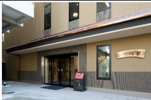
新館 エントランス
