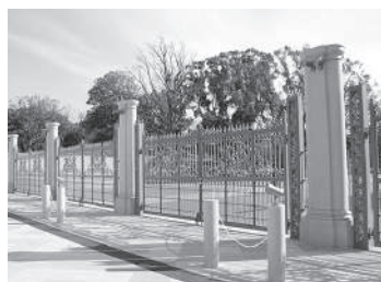
門柱と門扉は明治期に建設した旧正門の意匠を踏襲
