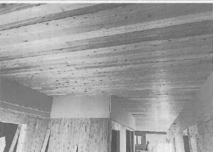
建築中のCLT天井。現在は石膏ボードによる被覆の作業が進む
