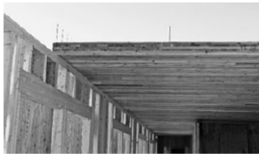
ツーバイフォー工法とCLT材を組み合わせる
